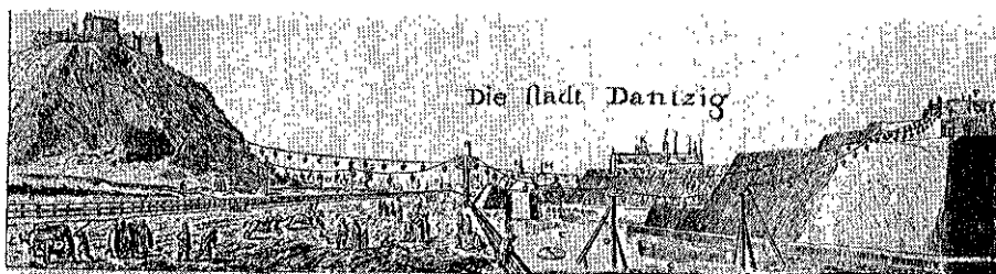
De eerste kabelbaan, toegepast in 1644 door de Nederlander Wybe Adams van Harlingen bij de bouw van een fort voor de stad Danzig
